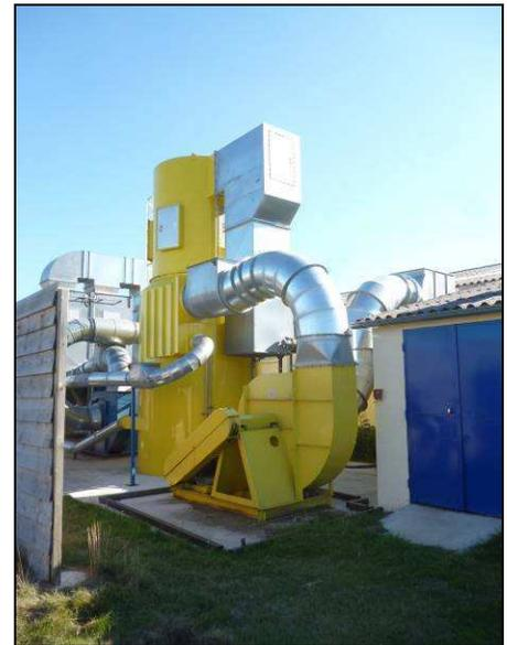
Des événements anti-explosion sont installés sur l'unité de filtration. Dans la partie supérieure de l'unité filtrante, une rampe de sécurité incendie est installée (1 pulvérisateur), celle-ci étant reliée en partie basse du filtre à un raccord pompier.
